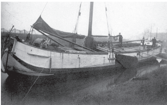
13. Een van ijzer gebouwd 'overgangstype' van de praam naar de Hasselter aak. Veel details zijn identiek aan die van de houten Overijsselse praam. De kop van dit schip heeft nog het voor een praam kenmerkende hoge, terugvallende boeisel en de steil oplopende berghouten. Wegens het ontbreken van een voorsteven werd dit scheepstype ook wel praamaak genoemd.
