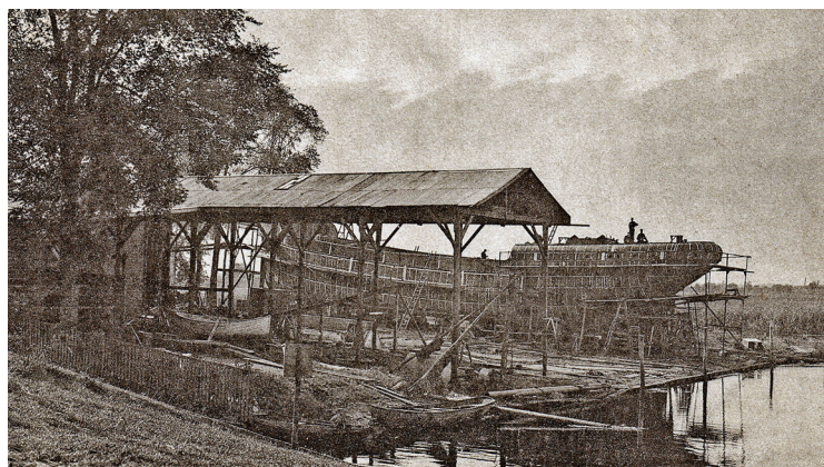
6. Scheepswerf Van Aller omstreeks 1910. Op de nieuwbouwhelling is de driemastschoener Acda in aanbouw.
