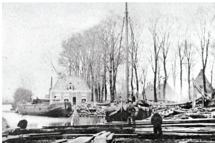
5. Winters tafereel omstreeks 1880 van scheepstimmerwerf Van Aller aan de Buitengracht. Rechts op de werf een schip in aanbouw, voor de wal twee Overijsselse pramen. Het schip links lijkt nieuw; zwaarden en roer ontbreken nog. Op de achtergrond v.l.n.r. de woningen van Nieuwenhuis (afgebroken circa 1970), Admiraal en Overmars (afgebroken circa 1955).
